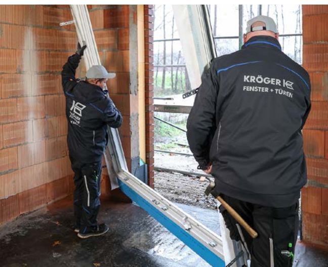
Einstellen des bodentiefen Fensters
